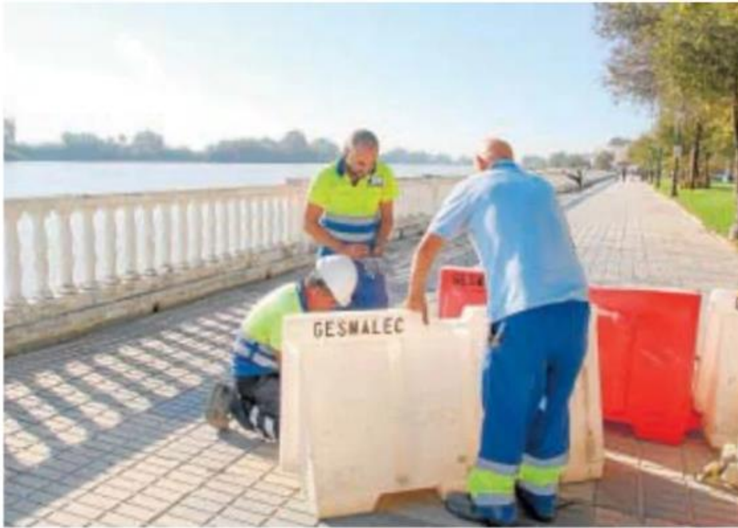
Imagen de archivo de los controles de las tuberías // ABC
